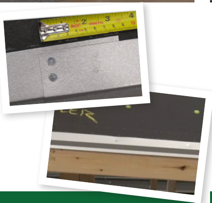
Superposición mínima de 3" – asegure con dos clavos
